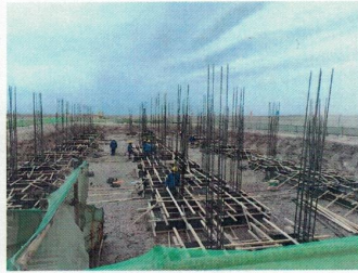
3月30日现场开挖监测
