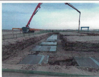
3月27日基坑开挖拦挡措施
